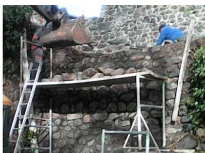
Suite à un éboulement du mur de soutènement se situant dans le chemin sous l'église, l'entreprise PASTRE de FIX SAINT GENEYS a procédé à sa réfection.
